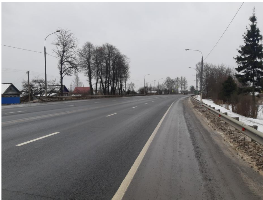
15. ПК 4+40. Вид в направлении Санкт-Петербурга.
