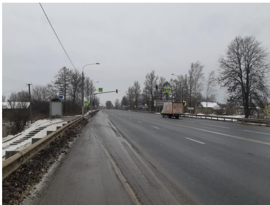
12. ПК 3+80. Общий вид на начало трассы, пешеходный переход.
