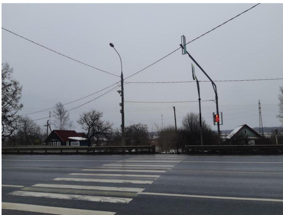
4. ПК 1+44. Общий вид справа, пешеходный переход.
