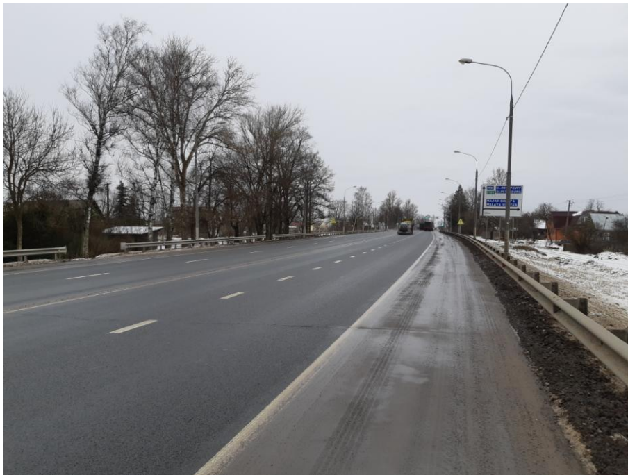
1. ПК 0+00. Вид в направлении конца трассы.
