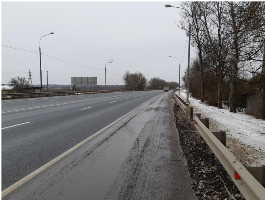
2. ПК 0+00. Вид в направлении Москвы.
