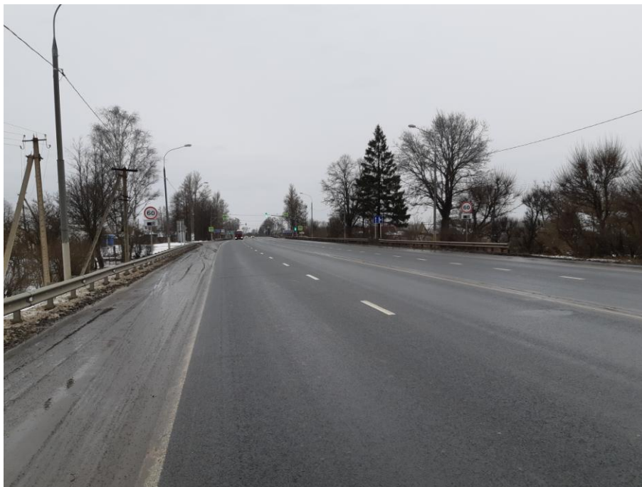
3. ПК 0+30 вид в направление конца трассы.
