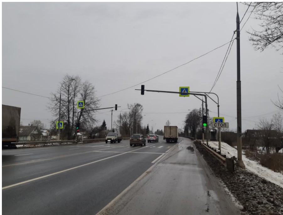
11. ПК 3+55. Общий вид на конец трассы, пешеходный переход.
